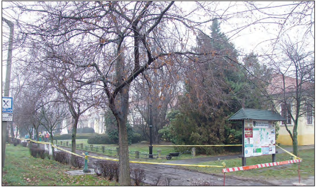
A Szabadság utcai járdafelújítás első szakasza megkezdődött
