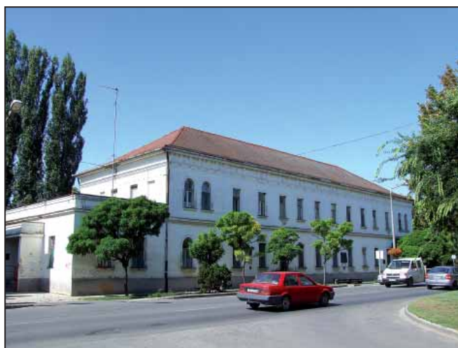
Szakorvosi rendelőintézet teljes felújítás, a Széchenyi utca felőli épületrészre magastető építése – DAOP - 4.1.1/B - 2008 - 0006. Bekerülés 581.663.000 Ft, támogatás 523.496.700 Ft
