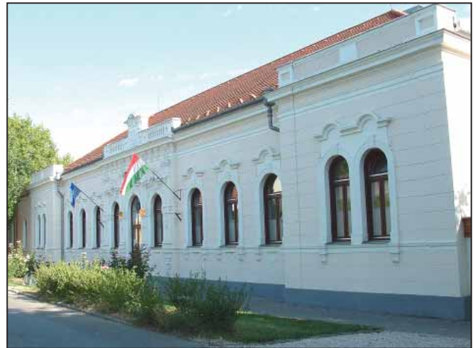
Kossuth Lajos utca 23. Városi fürdő épült 1903-ban, Popják György építőmester tervei szerint. Szimmetrikus homlokzatú, eklektikus stílusú épület. A szépen tagolt homlokzathoz kiemelkedik a gazdagon díszített bejárat. Felette kétoldali baluszter sorral a fürdő felirat.
