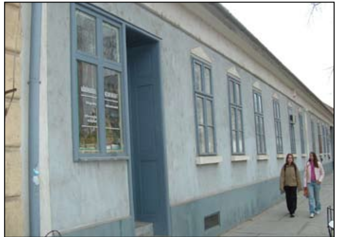
Deák Ferenc utca 4. Ügyvédi irodák. 1910 körül épült, földszintes, egyszerű megjelenésű lakóház. Utcaképi szempontból fontos.
