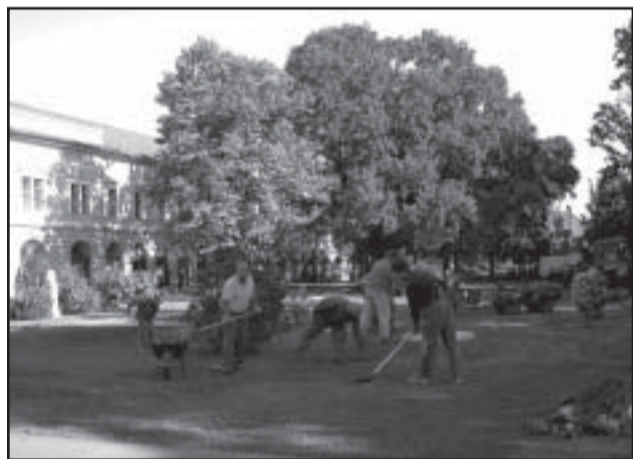
A Mitrovszky-kastély belső falainak utólagos nedvesség elleni szigetelésére „Nemzeti Kulturális Örökség” program keretén belül 3.384 eFt támogatást kaptunk. A munka befejeződött. A kastély belső felújításának sorsa jelenleg a „Városrehabilitáció” címen futó uniós pályázatunk elbírálásától függ.
