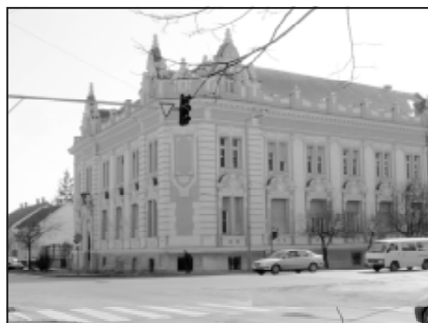
Magyar Államkincstár Békéscsabai Fiók – rekonstrukció –
