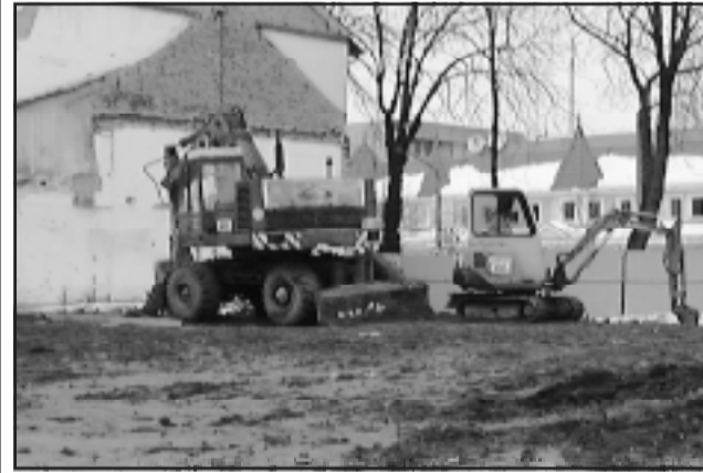
Mostmár az óvoda bontása következik, az időjárás azonban nem kedvez a kivitelezésnek
