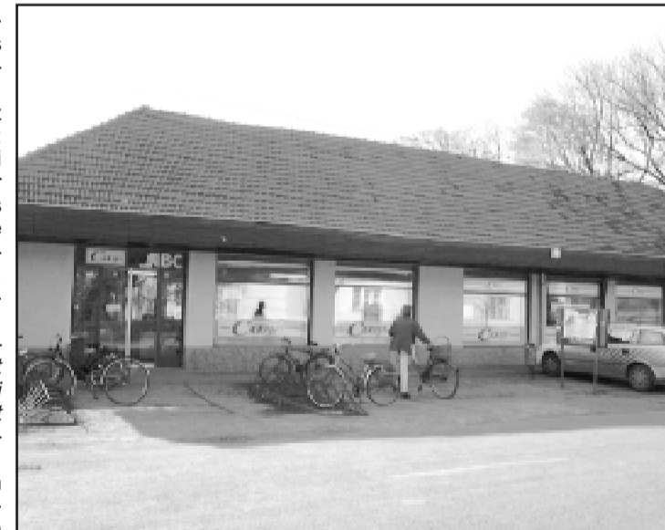
A felújított csabacsüdi Coop-boltban nemsokára kiépítik a légkondicionáló berendezést is.
