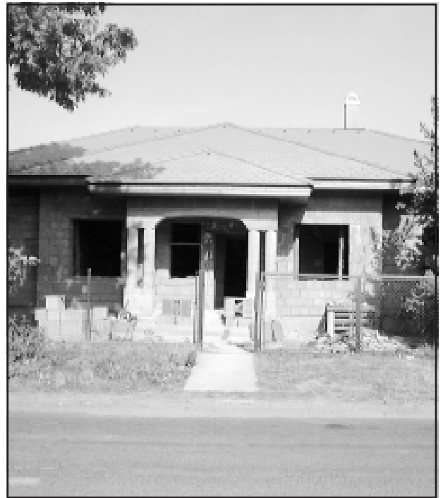
Egy épülő új családi ház a JOAMIT Bt kivitelezésében.
