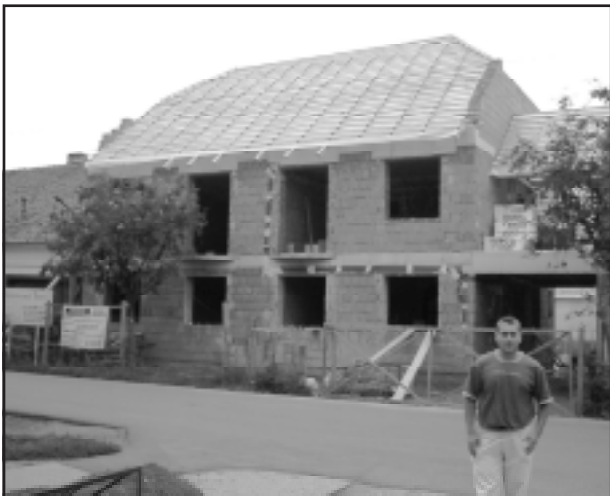
November végén adják át Kondoroson az Integrál szakemberei a 4 illetve 6 lakásos szociális bérlakást. Felvételünkön a Wesselényi utcai négylakásos ház látható, a kép előterében Bódi Péter, az építkezés felelős műszaki vezetője.
