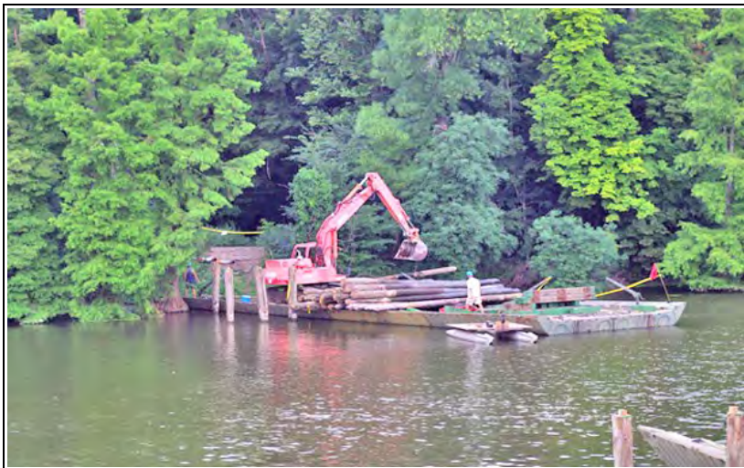
Kezdődik a híd alapozása
