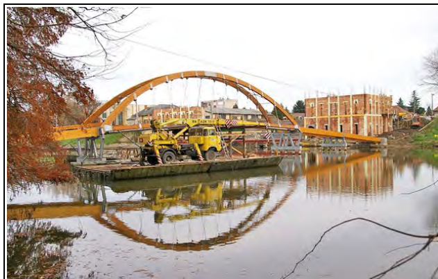
A híd teljes tartószerkezeti váza
