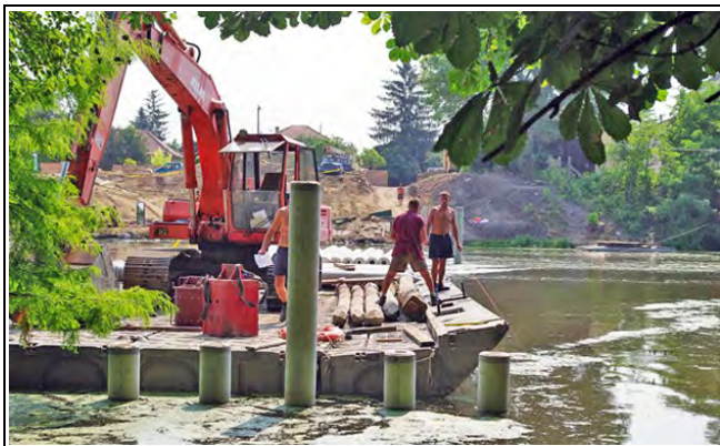
Zsaluzzák és szerelik az északi bástya lábazati összekötő fejgerendáját
