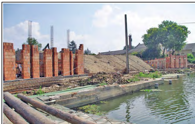
Falazzák a bástyákat, és készül a nézőtéri szerelőbeton
