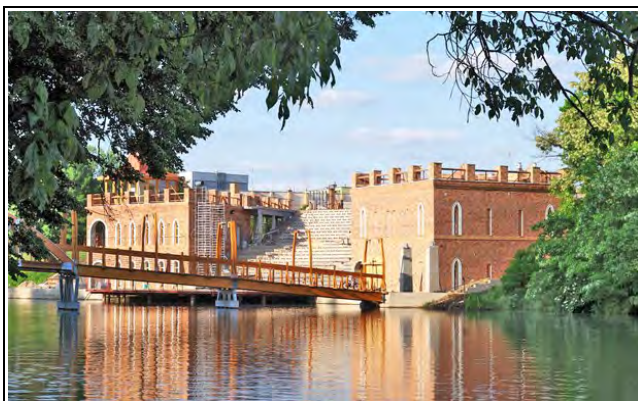
A híd egyenes szakasza a korlát- elemekkel
