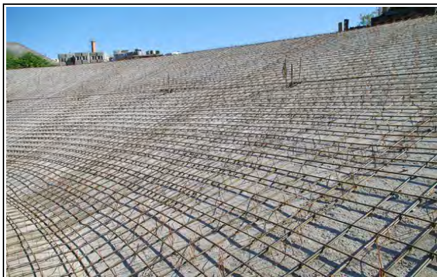
Szerelik a nézőtér acél-armatúráját
