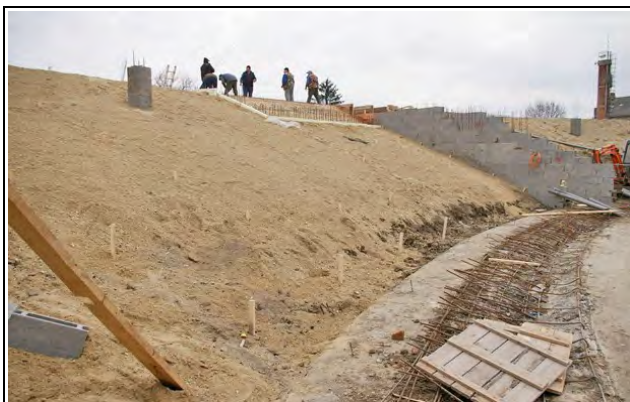
Készül a nézőtéri felső karéj földfeltöltése
