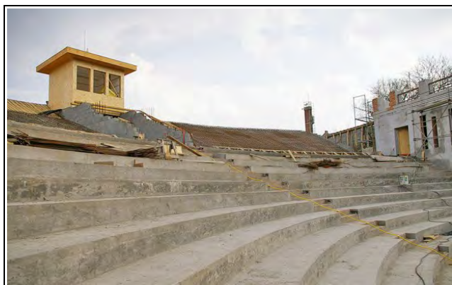
Folyik a felső karéj betonozása
