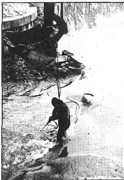
Épül az új híd
