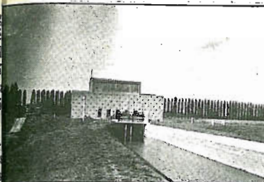
A kákafoki szivattyútelep
